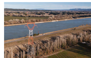
Au nord - Couloir de lignes à 225 000 volt
